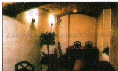
Termiczna i akustyczna izolacja stropu restauracji
